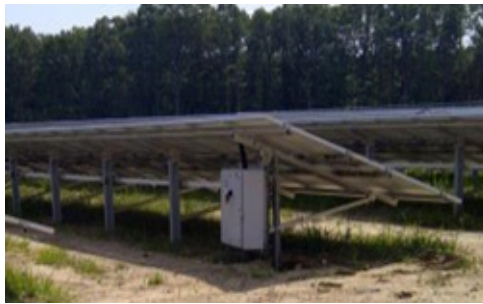
Gambar 7 Modul surya, kotak combiner, struktur rangka, kabel. Sumber: Triad Engineering. Foto: Dan Jordan
