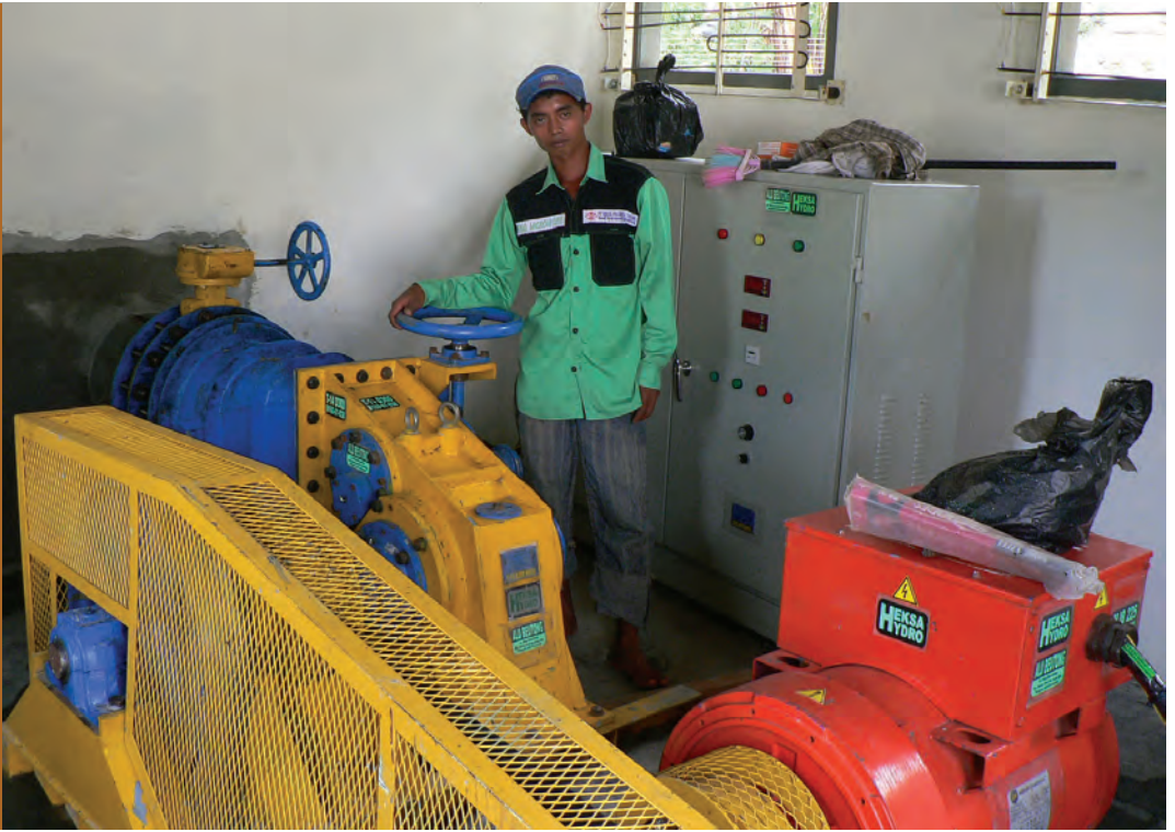
Turbin cross-flow dan generator, Bandung, Jawa Barat
