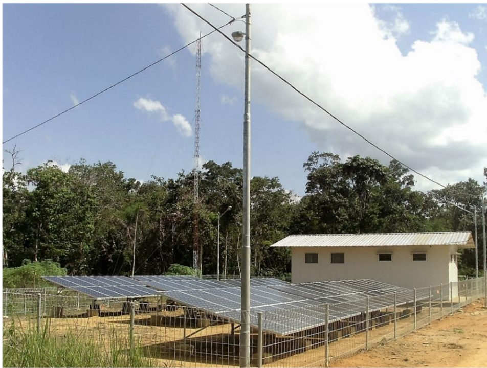
• • • • • Tipikal sistem pembangkit listrik tenaga surya terpusat off-grid dengan larik (array) fotovoltaik dan rumah pembangkit yang berisi komponen elektronik dan baterai.
